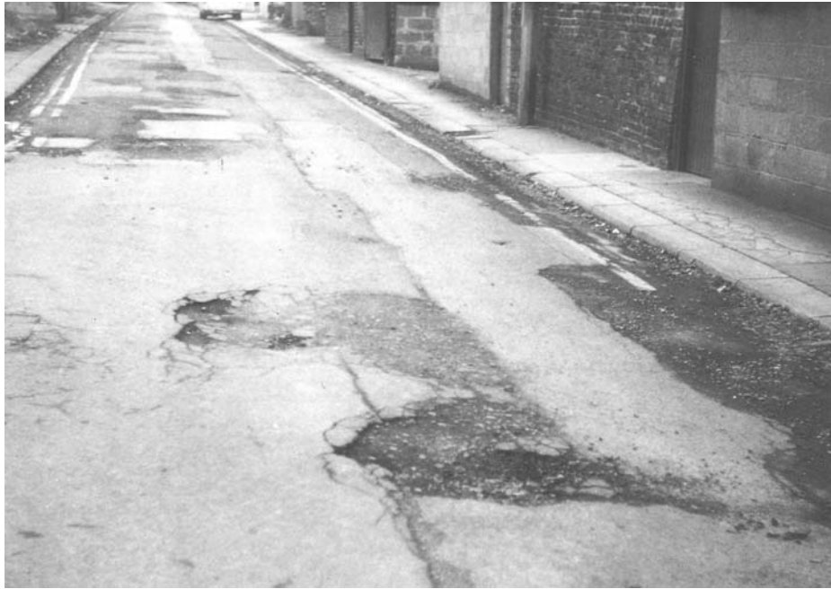
(ج) انهيار الرصف
