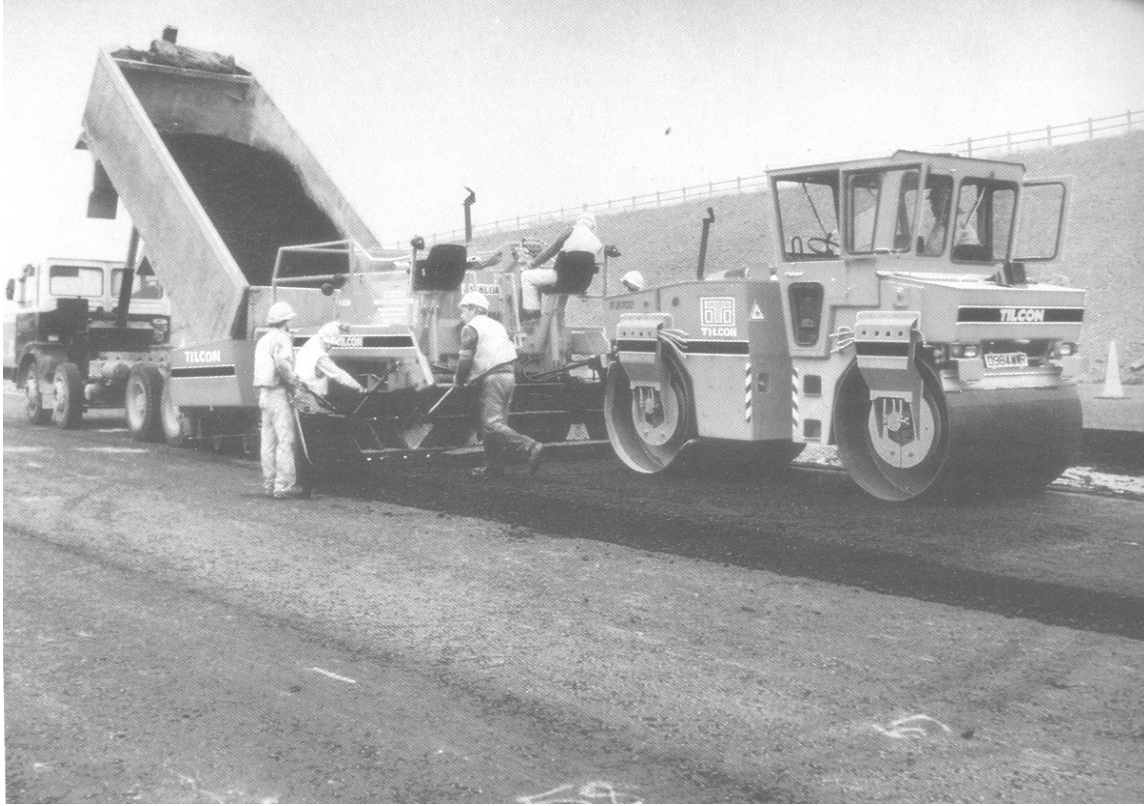
شكل (٣,٥) وضع طبقة جديدة على سطح موجود.
