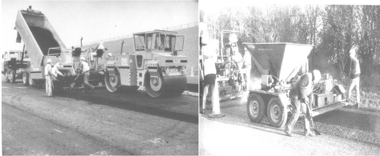
شكل (٢,٤) عملية إنشاء الرصيف المرن.
