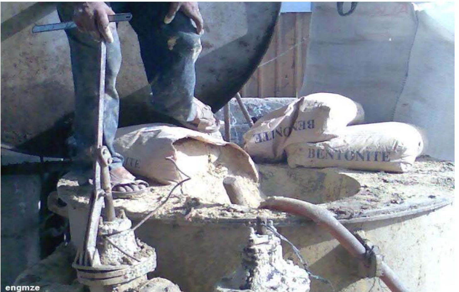
ثم يقومون بسكب الشكاير في خزان خلاط مع الماء لتحضيرها سائل البنتونيت كما في الصورة
