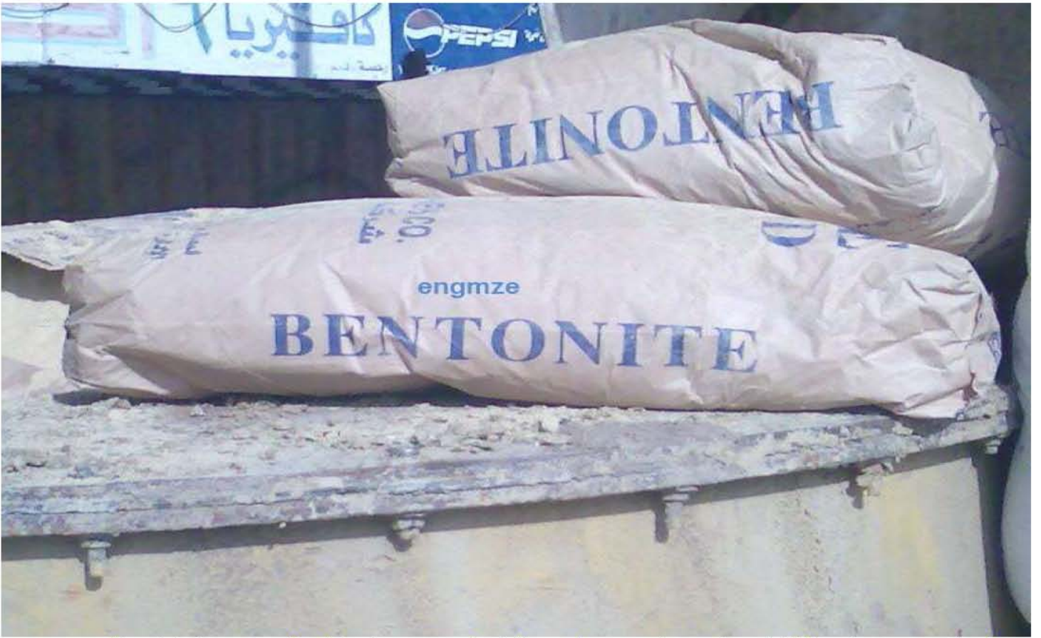
ثم يقومون بسكب الشكاير في خزان خلاط مع الماء لتحضيرها سائل البنتونيت كما في الصورة
