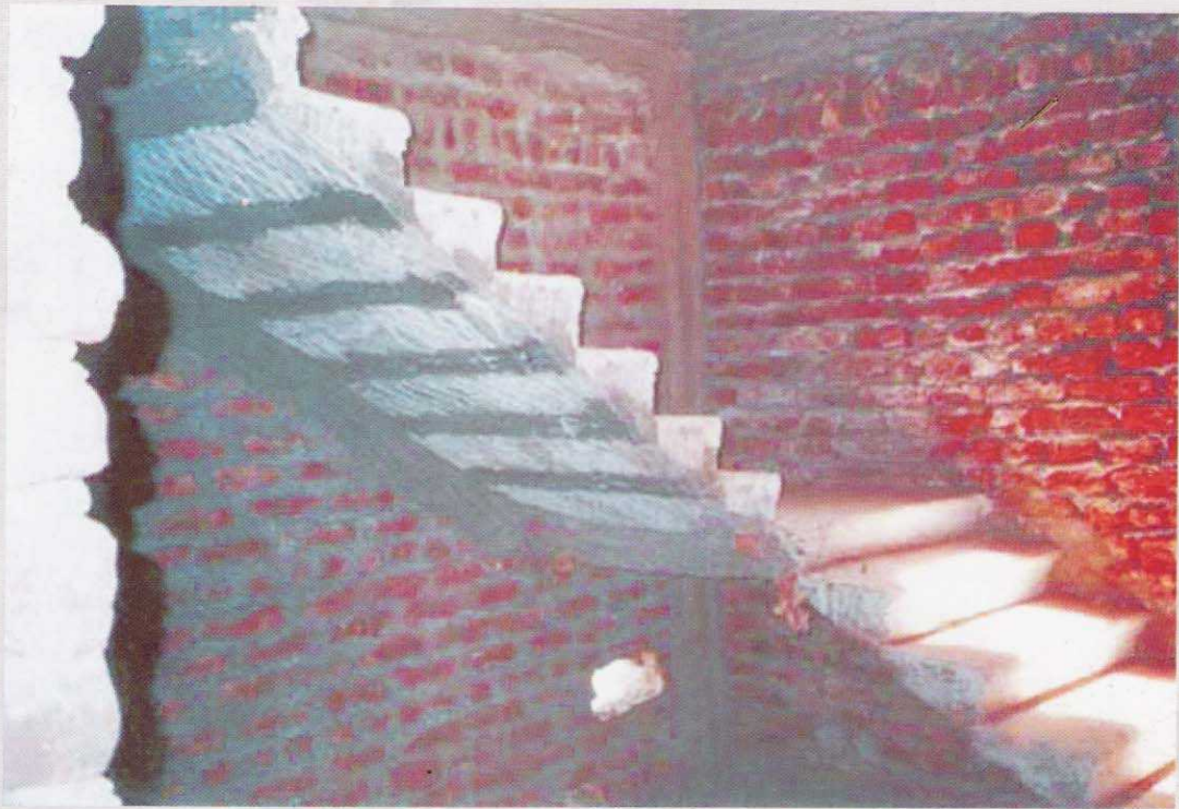
• سلم من الموزايكو منضد بطريقة الكابولي ويسمى باذنجانة .
