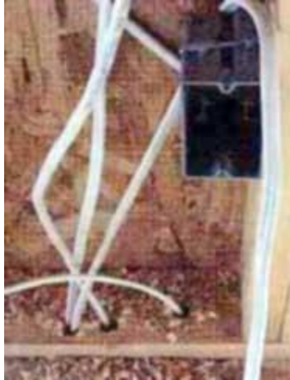
تركيب الأسلاك بعد تركيب المواسير
