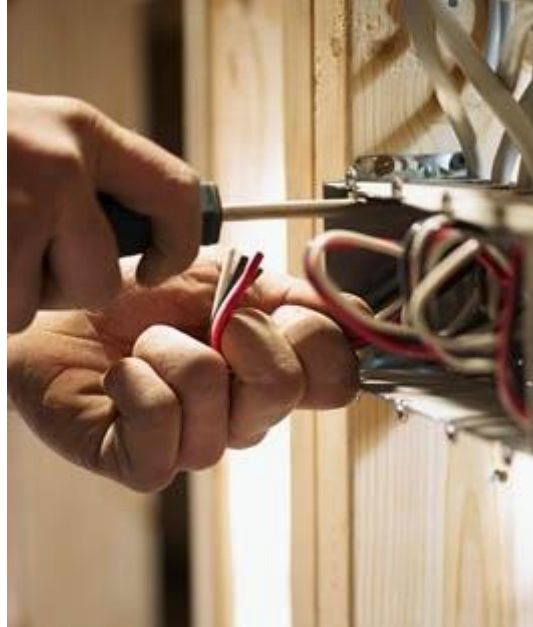
تركيب علب الكهرباء
