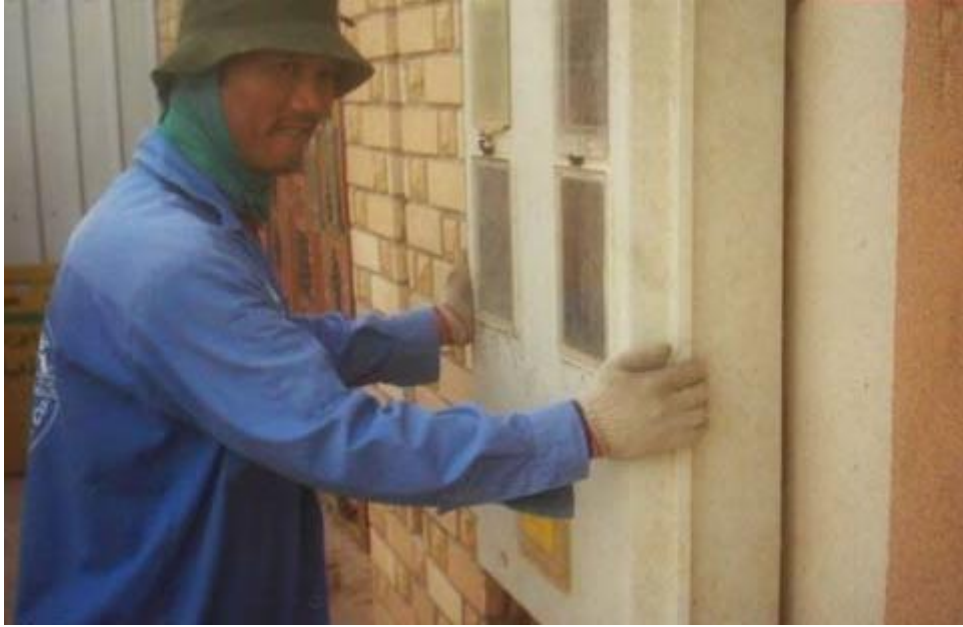
تركيب التابلوه الكهربائي
