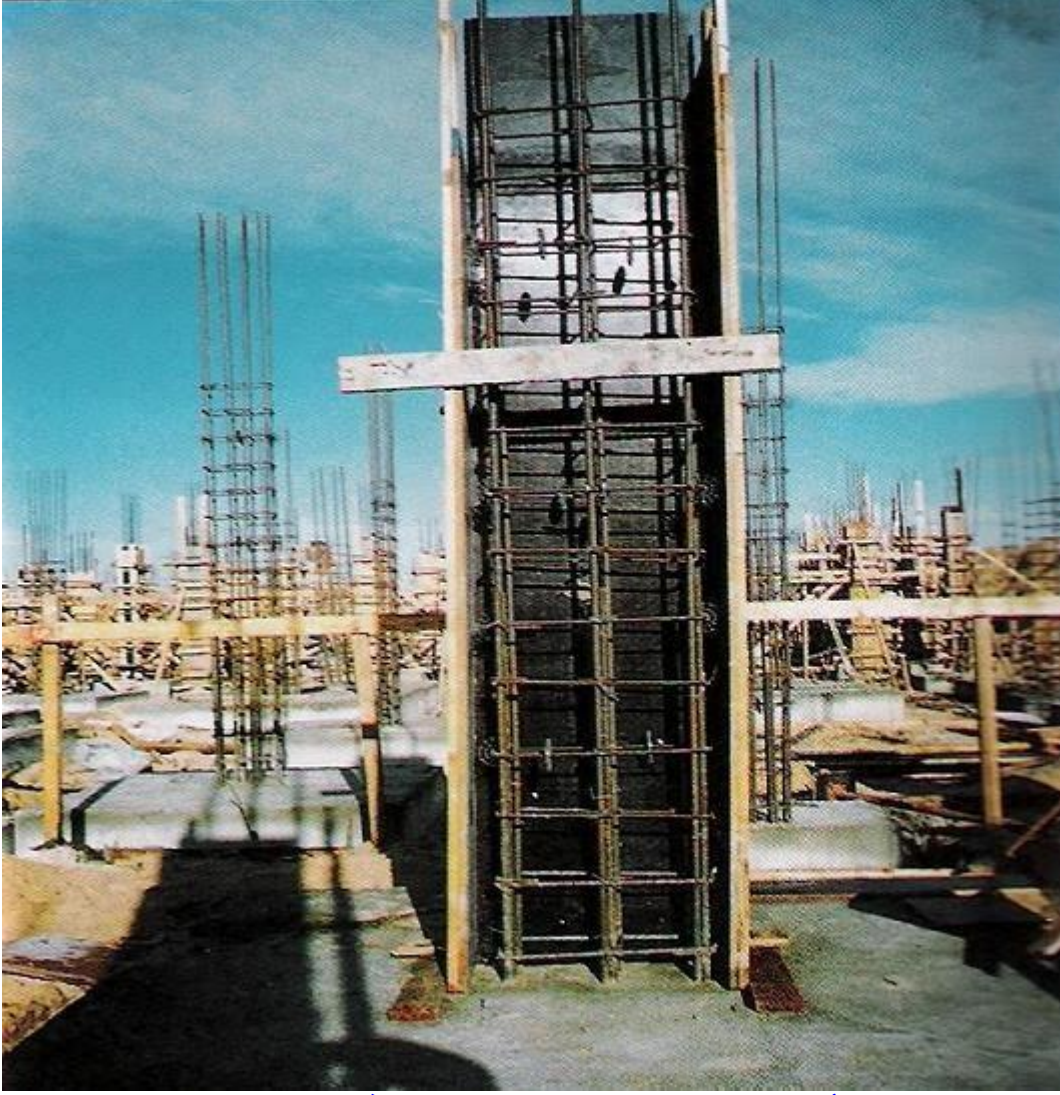
أعمال تسليح عامود تظهر به الكانة الصندوق
