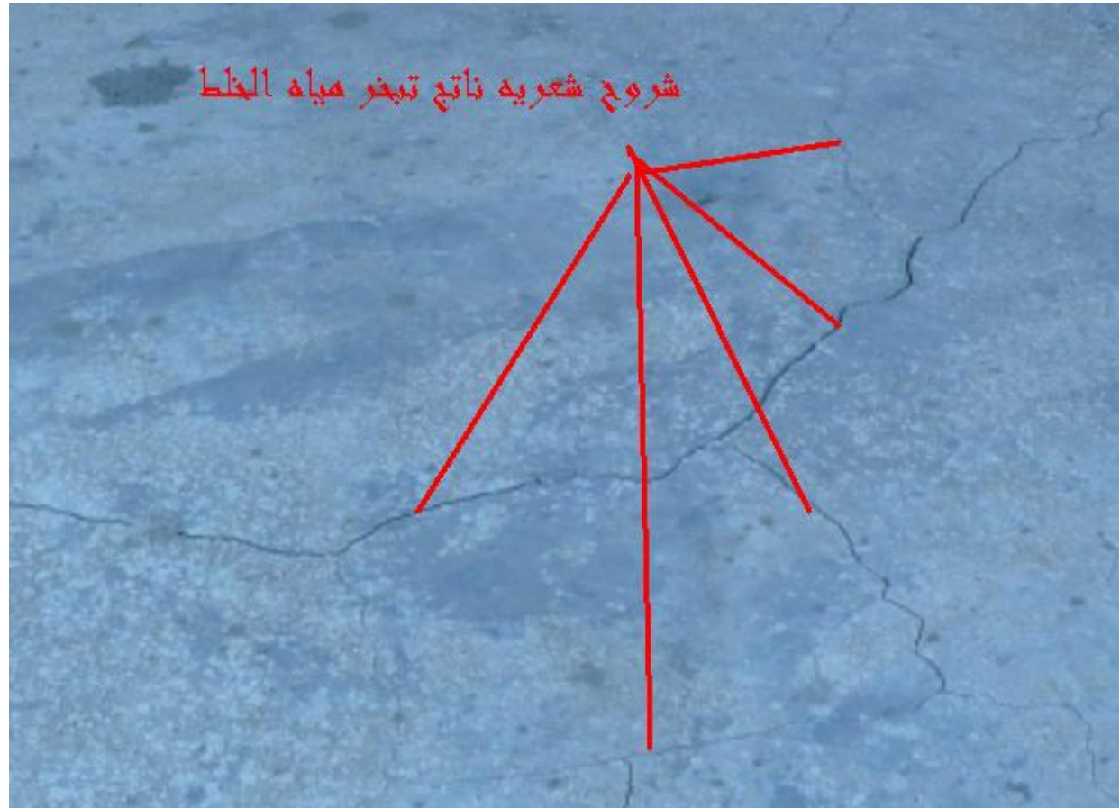
صورة الشروخ الشعريه ناتج تبخر مياه الخلط
