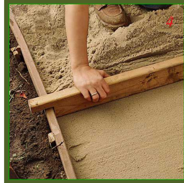
3- يتم تسوية الرمل الذي يوضع فوق الطوب المكسر
