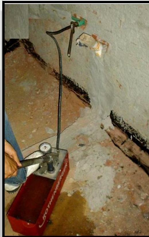
اختبار المواسير بالحوائط
