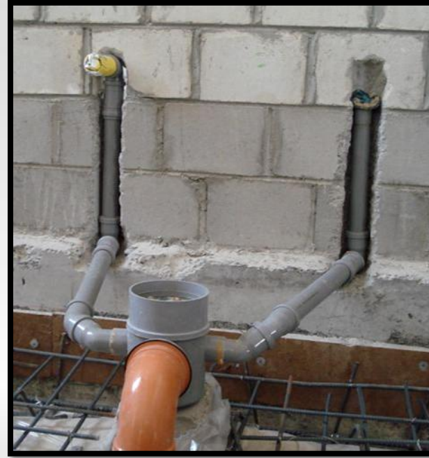
تنفيذ شبكة الصرف الصحي الداخلية
