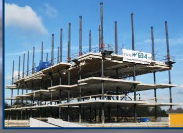
نظام البلاطات المرفوعة أثناء التنفيذ و رفع البلاطات
