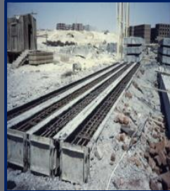
عدم الحاجه الى الشدات التقليديه
