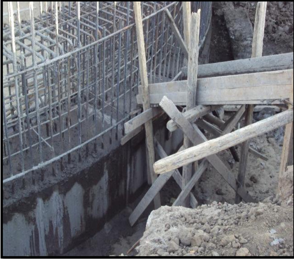
شكل رقم (١٢) مرحلة صب الضافر
