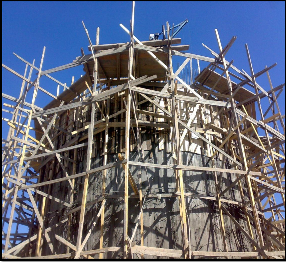
شكل رقم (١٤) تتابع صب الحطات العليا
