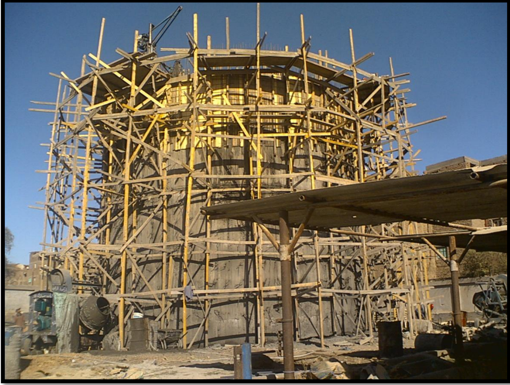
شكل رقم (١٦) تتابع صب الحطات العليا
