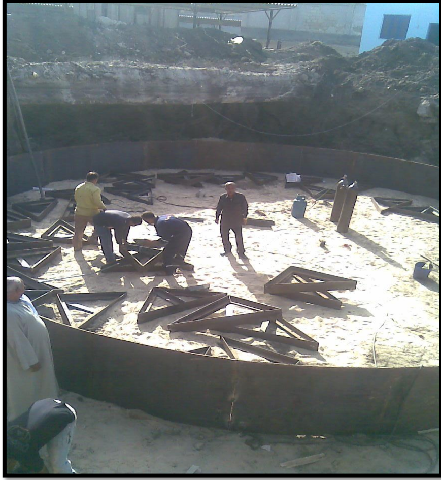
شكل رقم (٧) تجميع الغريم الداخلي للخنزيرة (الضافر)
