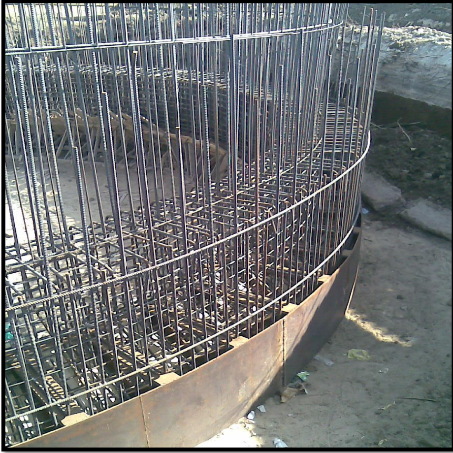
شكل رقم (١١) انتهاء تسليح الضافر وانتهاء عمل أشاير الحائط العلوي
