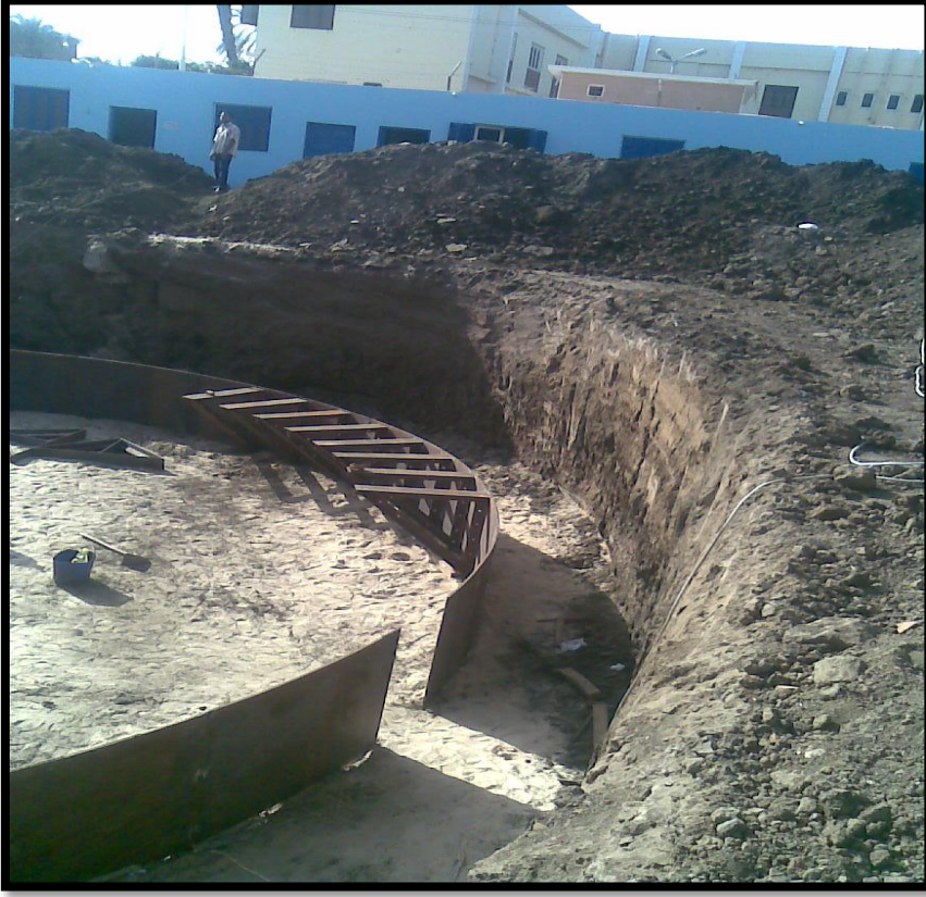
شكل رقم (٦) تجميع المحيط الخارجي للخزيرة (الضافر)
