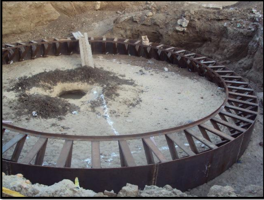
شكل رقم (٩) بعد اكتمال لحامات حديد الخنزيرة
