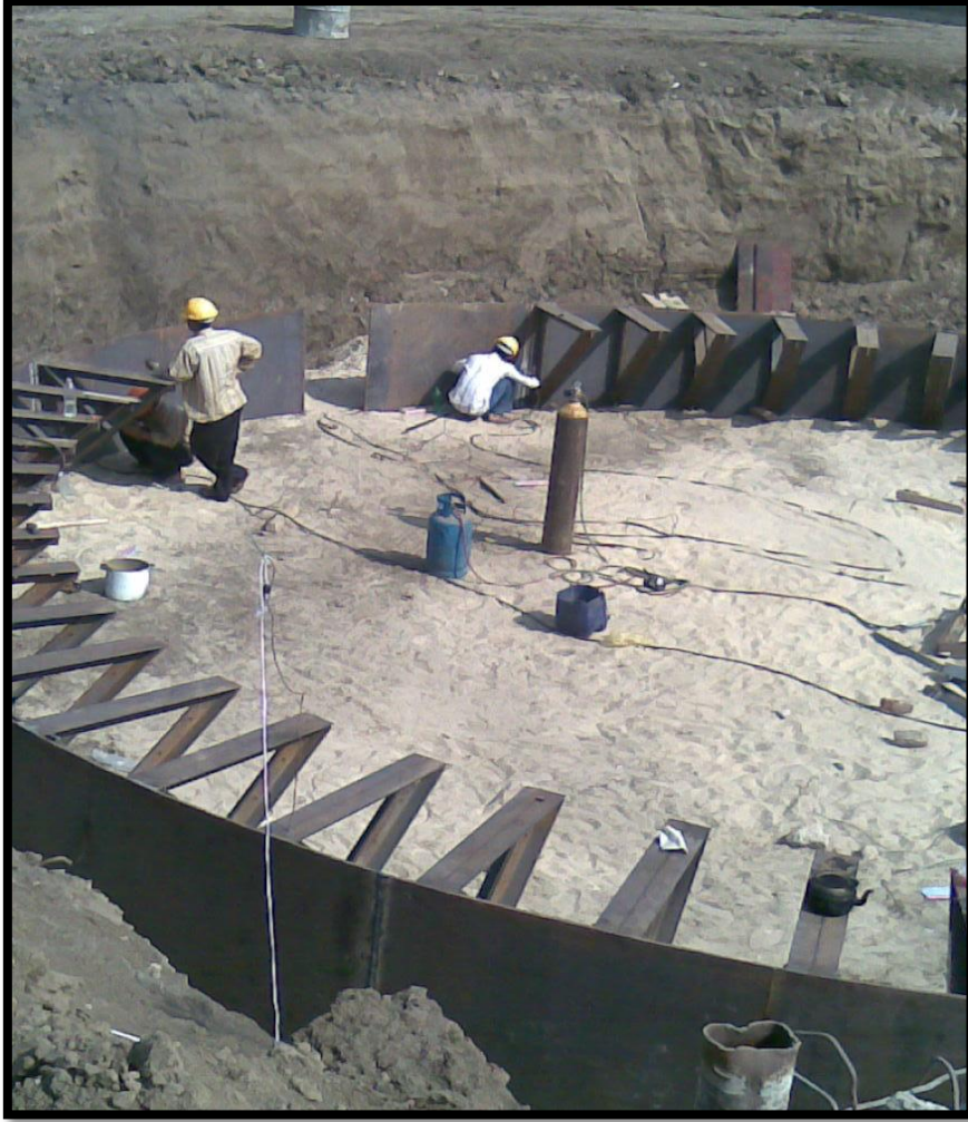
شكل رقم (٨) تجميع الفريم الداخلي للخنزيرة
