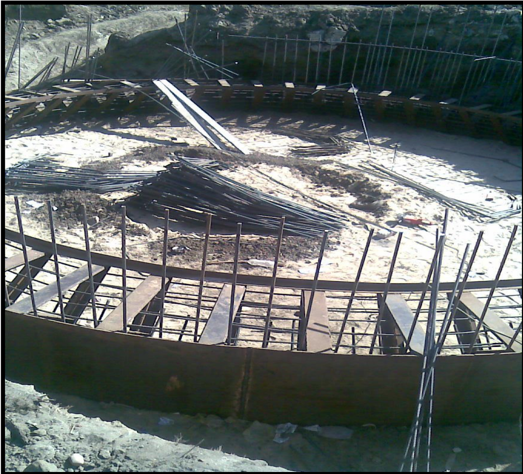
شكل رقم (٩) بعد اكتمال لحامات حديد الخنزيرة
