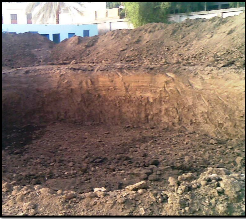
شكل رقم (٥) يلاحظ انه لم نصل الي منسوب المياه الجوفيه
