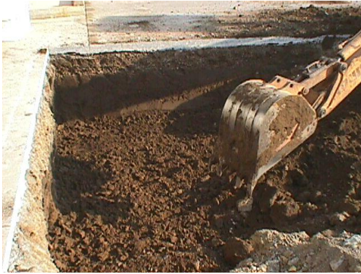
شكل 5: (أ) الحفرة عقب الإنتهاء وتظهر جوانبها المستوية (ب) عمليّة حفر أساس باستخدام آليّة الحفر
