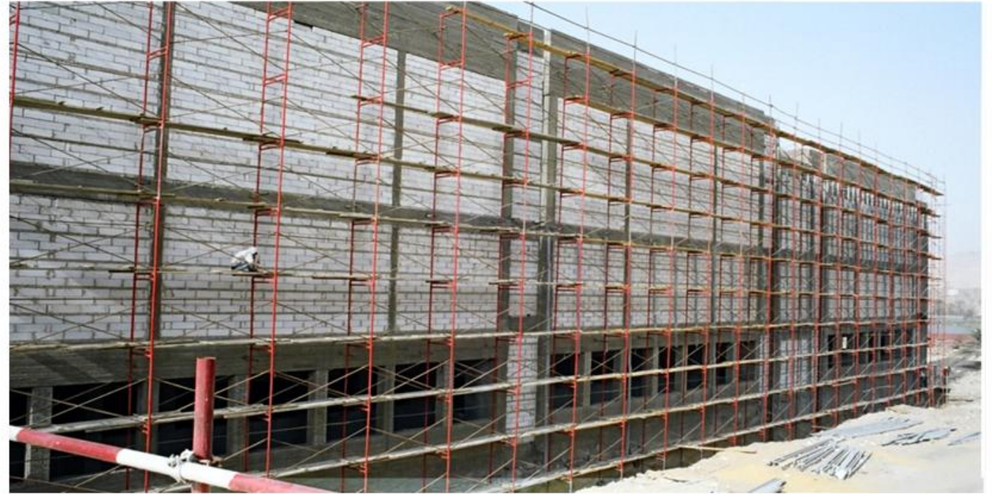
اعمال تركيب الشاسية المعدني
