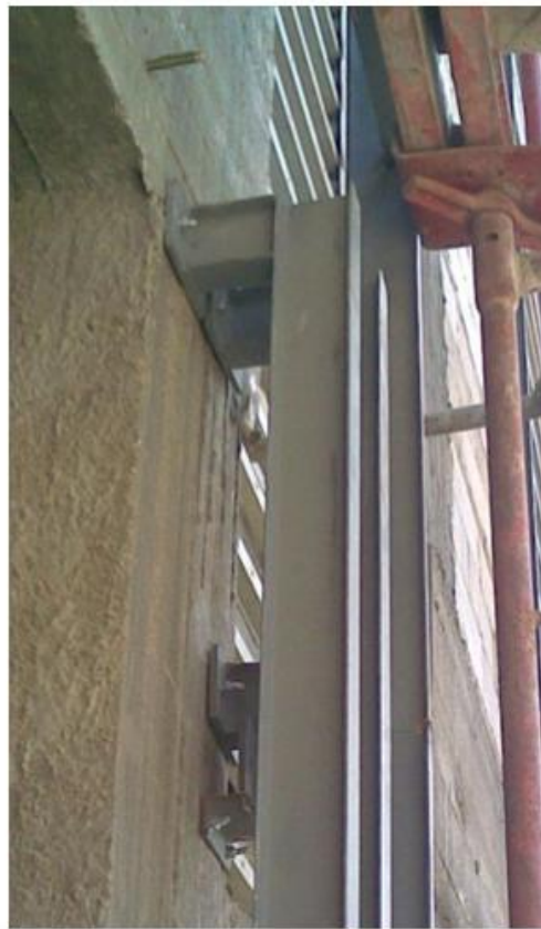
صور توضح طريقة التثبيت الشاسية في الخرسانة
