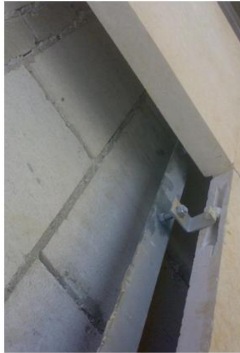
تفصيلية توضح تركيب الرخام علي الكانة
