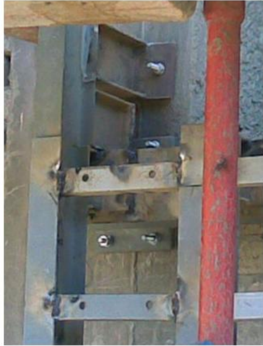
صور توضح طريقة التثبيت الشاسية في الخرسانة
