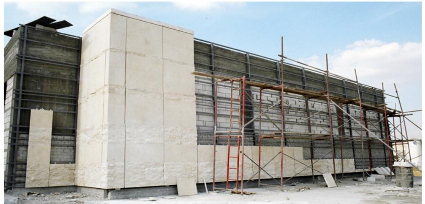
اعمال تركيب الرخام
