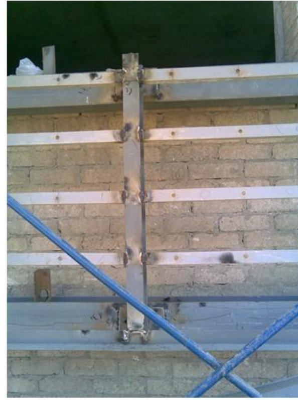
تفصيلية توضح لحامات اجزاء الشاسية
